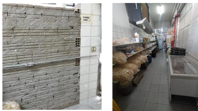
Figura 2 – Parede sem azulejo na panificadora, antes e depois.
